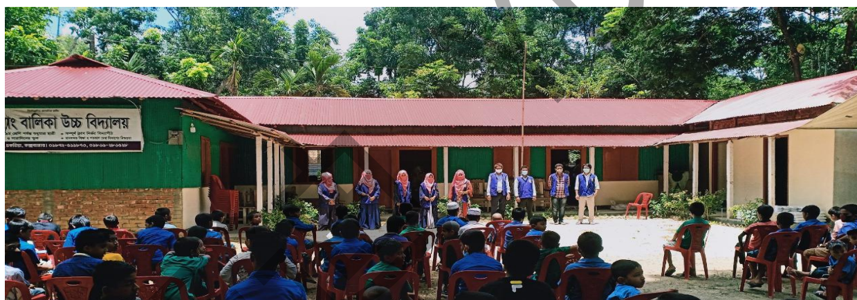
2020 年，项目执行期间为孟加拉国 Harbang 区学校修缮的图书阅览室。
